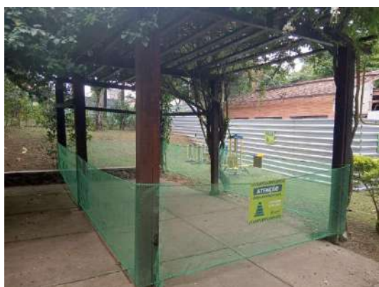
Figura 75: Reforma pergolado, antes.
