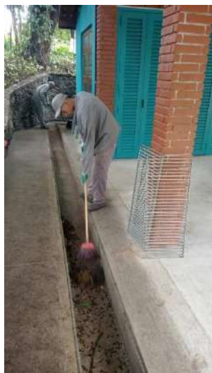
Figura 52: Limpeza grelhas de captação de água pluvial, antes.
