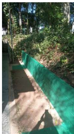
Figura 80: Muro de contenção, depois.
