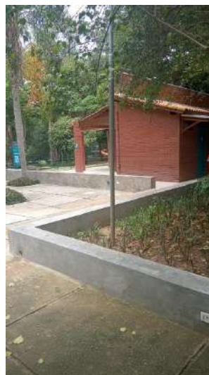
Figura 72: Novos bancos de cimento queimado.
