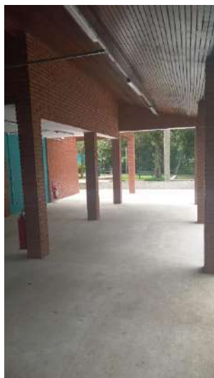
Figura 71: Pisos de concreto do prédio de uso público refeito.
