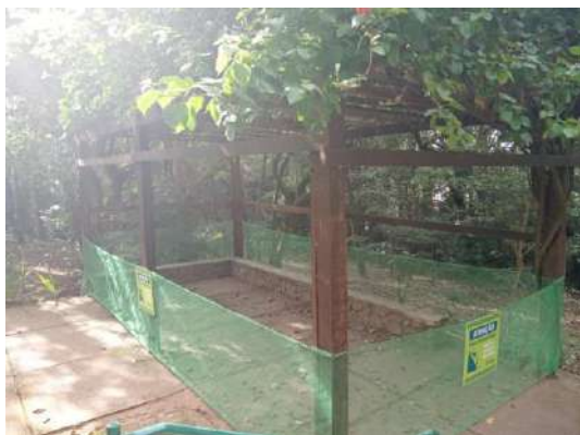
Figura 77: Reforma pergolado, antes.
