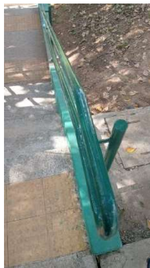
Figura 82: Pintura corrimão, depois.
