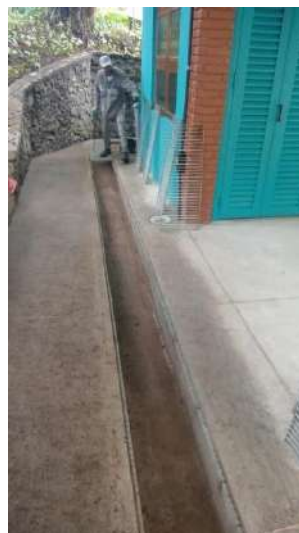
Figura 53: Limpeza grelhas de captação de água pluvial, depois.
