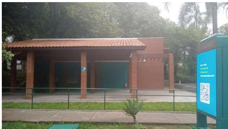
Figura 73: Prédio de uso público totalmente reformado
