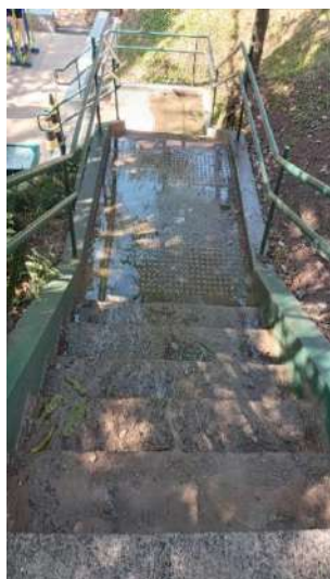
Figura 50: Limpeza com lavadora de alta pressão, antes.
