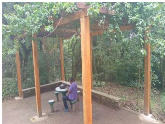
Figura 78: Reforma pergolado, depois.
