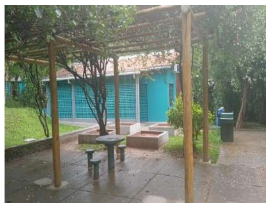
Figura 76: Reforma pergolado, depois.
