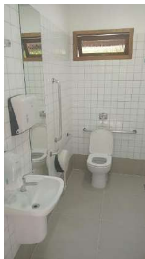
Figura 69: Novo banheiro PCD de uso público.
