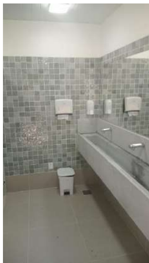
Figura 66: Banheiro de uso público feminino reformado.
