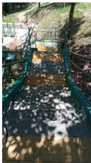
Figura 51: Limpeza com lavadora de alta pressão, depois.
