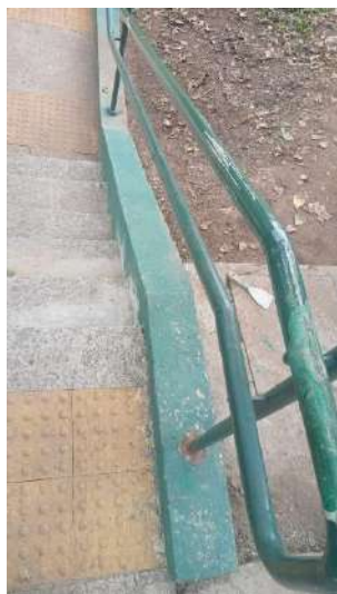
Figura 81: Pintura corrimão, antes.
