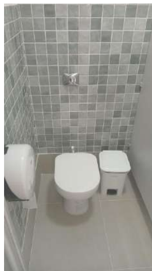
Figura 67: Banheiro de uso público feminino reformado.
