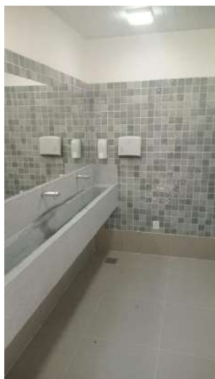
Figura 68: Banheiro de uso público masculino reformado.
